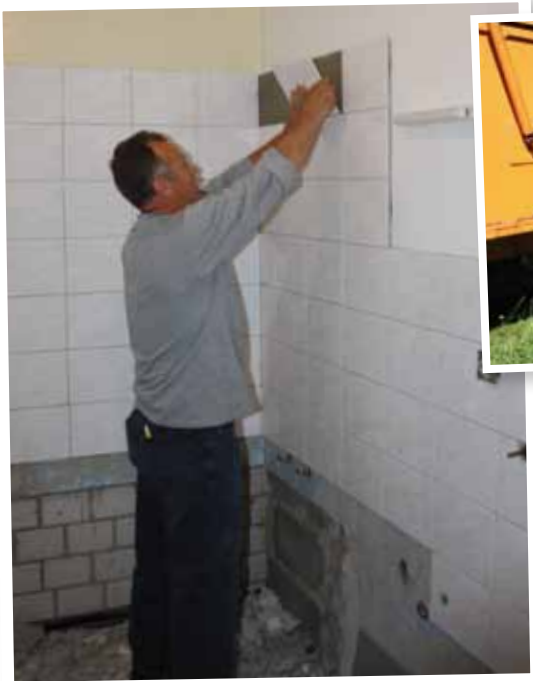
Wilhelm Grünwald (52), kümmert sich seit 11 Jahren um die Badezimmer der GBS. Hier müssen neue Fliesen an die Wand.
