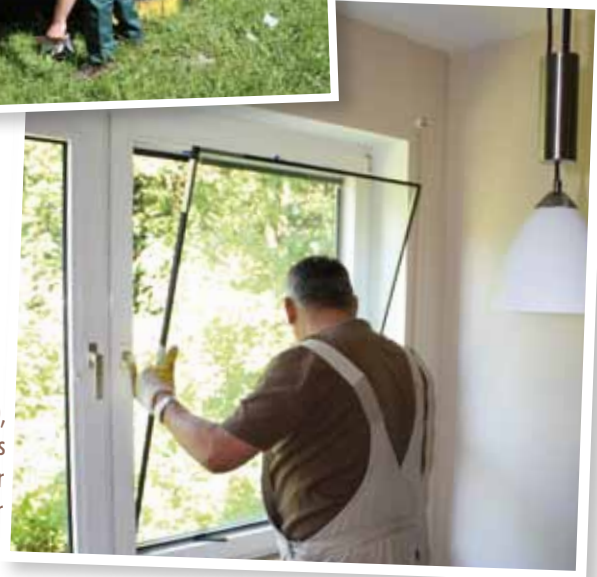
Ralf Lenk (46), baut ein neues Fenster ein. Er ist Schreiner bei der GBS.
