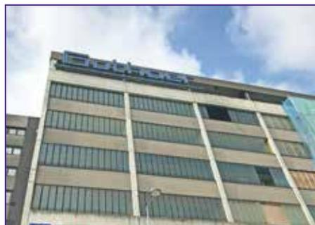
Am gesamten Gebäude wurde der alte Beton mit Hochdruckpumpen abgetragen, entsorgt und durch neuen Beton sowie einen Anstrich ersetzt. Für die angenehmere Nutzung des Parkhauses mit 250 Stellplätzen wurden mehrere Rampen verbreitert, so dass die schmalen Auffahrten nun der Geschichte angehören. Neben dem neuen Boden und den sanierten Wänden wurde auch eine zeitgemäße LED-Beleuchtung installiert und zudem die Wasserleitungen erneuert.
